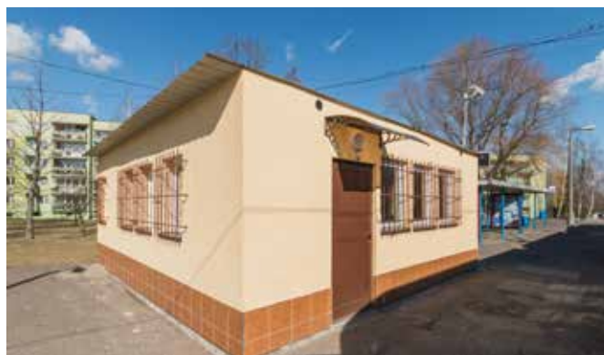
Wykonana została nowa elewacja, wyremontowano też dach
